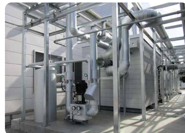
▲上：吸収式冷凍機（ジェネリンク） ▲左：停電対応型ガスコージェネレーションシステム
