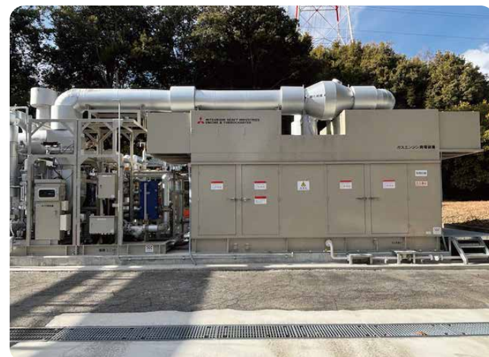
▲上：吸収式冷凍機（ジェネリンク） ▲左：停電対応型ガスコージェネレーションシステム
