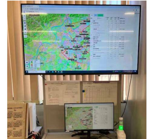
▲本社親局ガバナ遠隔監視システムPC及び液晶画面、タブレット
