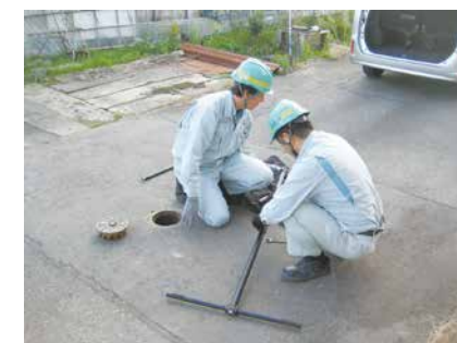
バルブ開閉器の組み立て作業
