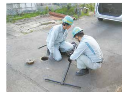
バルブ開閉器の組み立て作業
